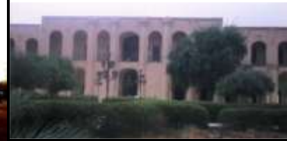
الشكل (10) واجهة القشلة قبل 1992
