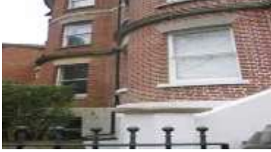
الشكل (6) يوضح حالات، إختلاف لغة الدرز ، تناقض حاد مع طابوق الجدران المجاورة.
