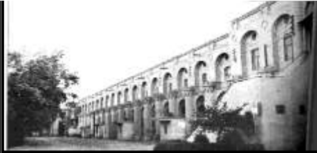
الشكل (8) واجهة القشلة قبل 1921
