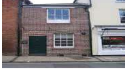
الشكل (6) يوضح حالات، إختلاف لغة الدرز ، تناقض حاد مع طابوق الجدران المجاورة.
