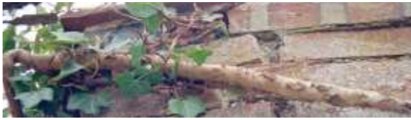
الشكل (7) الأشجار والشجيرات يمكن أن تسبب أضراراً جسيمة بالطابوق. المصدر
