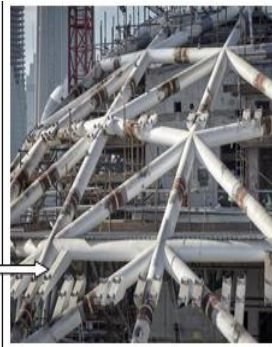
الهيكل الإنشائي للمتحف يتكون من جميع آلاف القطع المثلثة الشكل والتي تكون مقطوعة قطرياً، وتكون مادة هذه القطع هي الفولاذ المقاوم للصدأ.
