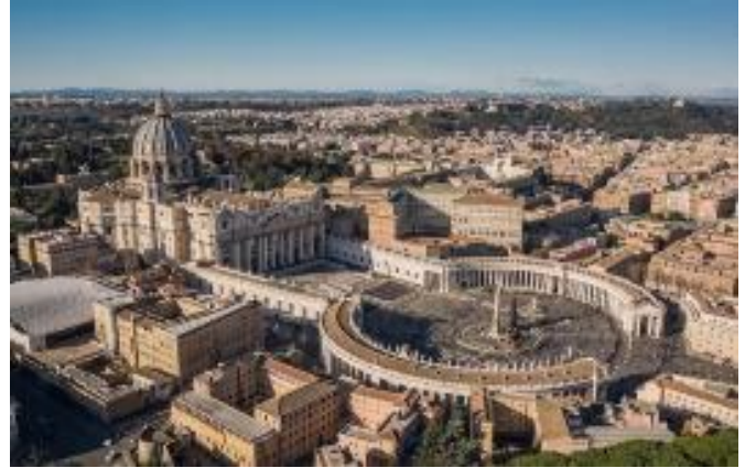
شكل (12): هيمنة قبة الكنيسة على سياق المنطقة ضمن وحدة وتكامل
