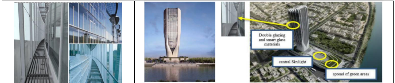
الشكل (3): يبين الميزات المستدامة لمبنى البنك المركزي العراقي، المصدر: (Aatty and Al Slik, 2019, p. 5).
